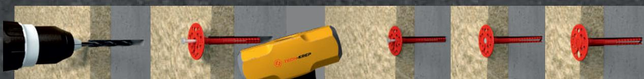
Просверлить отверстие через утеплитель
