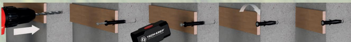
Просверлить отверстие через толщину закрепляемой детали
