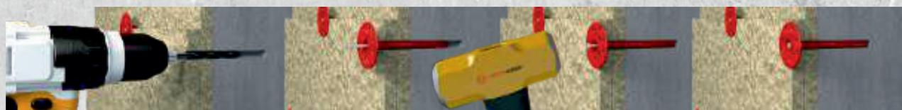
Просверлить отверстие через утеплитель
