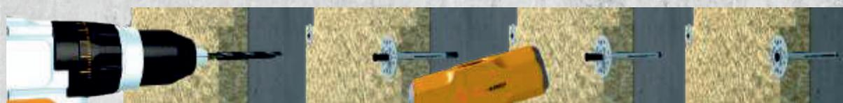
Просверлить отверстие через утеплитель
