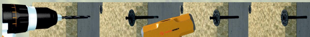
Просверлить отверстие через утеплитель
