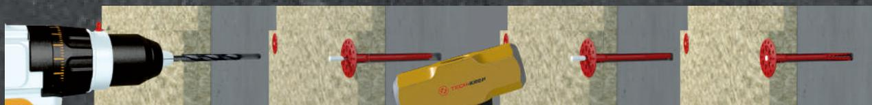
Просверлить отверстие через утеплитель
